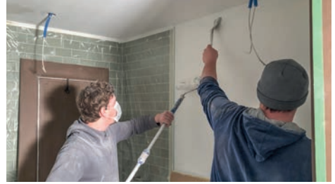
Arbeiten im Grandhotel Giessbach
